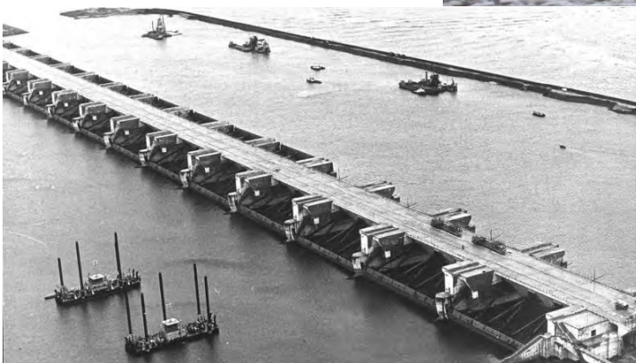
1969, de Haringvlietsluizen in aanbouw...
